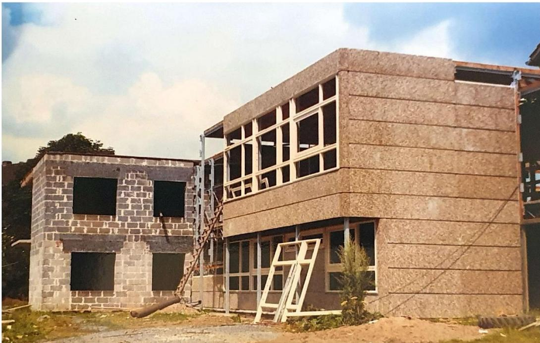
Auf dem Foto sind die tragenden Stahlstützen (grau, hinter der Leiter) des Gebäudes zu erkennen, an die die Fassadenplatten aus Waschbeton angehängt sind. Im Hintergrund das angebaute Wohnhaus in konventioneller Bauweise mit tragenden Wänden.
