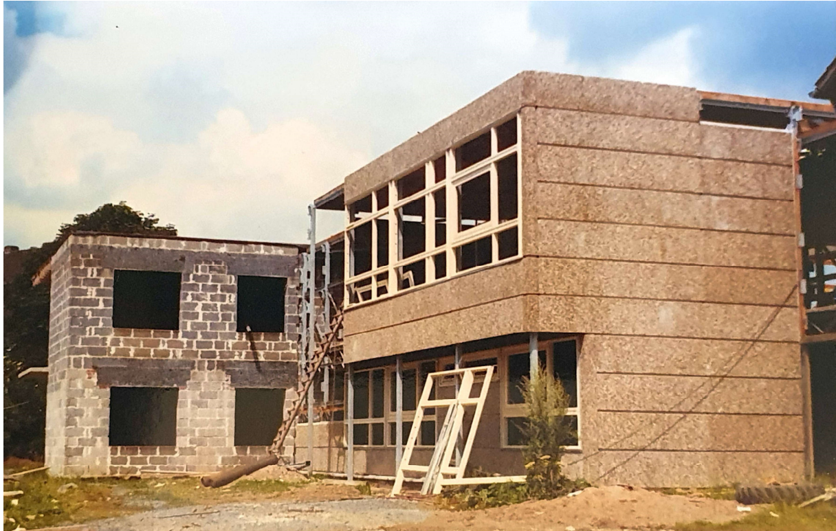
Bild aus der Bauzeit des Gemeindehauses. Im Hintergrund der Massivbau der Küsterwohnung. Davor erkennt man die Stützen der Stahlkonstruktion mit den Aufnahmen für die Waschbetonfassaden-Elemente. (Fassadenhalter)
